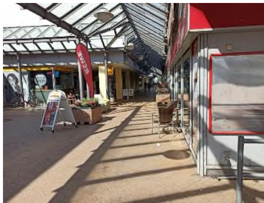
Foto 2: Ladenpassage, Blick vom südlichen Vorplatz
