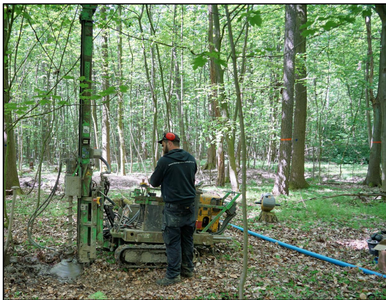
Abbildung 9: Bohrgerät zur Schneckenbohrung
