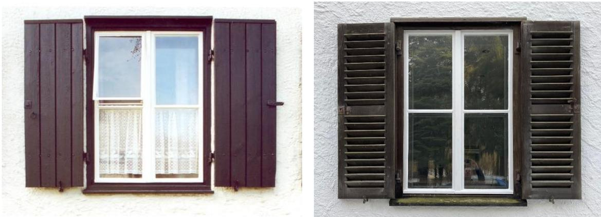
Abbildung 21: Bestandsfenster. Typen Fensterläden (Brettklappläden, Lamellenklappläden)
