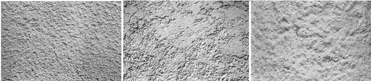
Abbildung 15: Kratzputz, Wurmputz und überquasteter Kellenwurfputz
